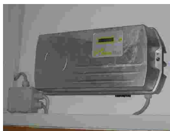
Bilder Photovoltaikanlage: Aufbau der Anlage auf dem Dach des Gemeindehauses Wechselrichter (Mitte), Display (typgleich, Rechts)
